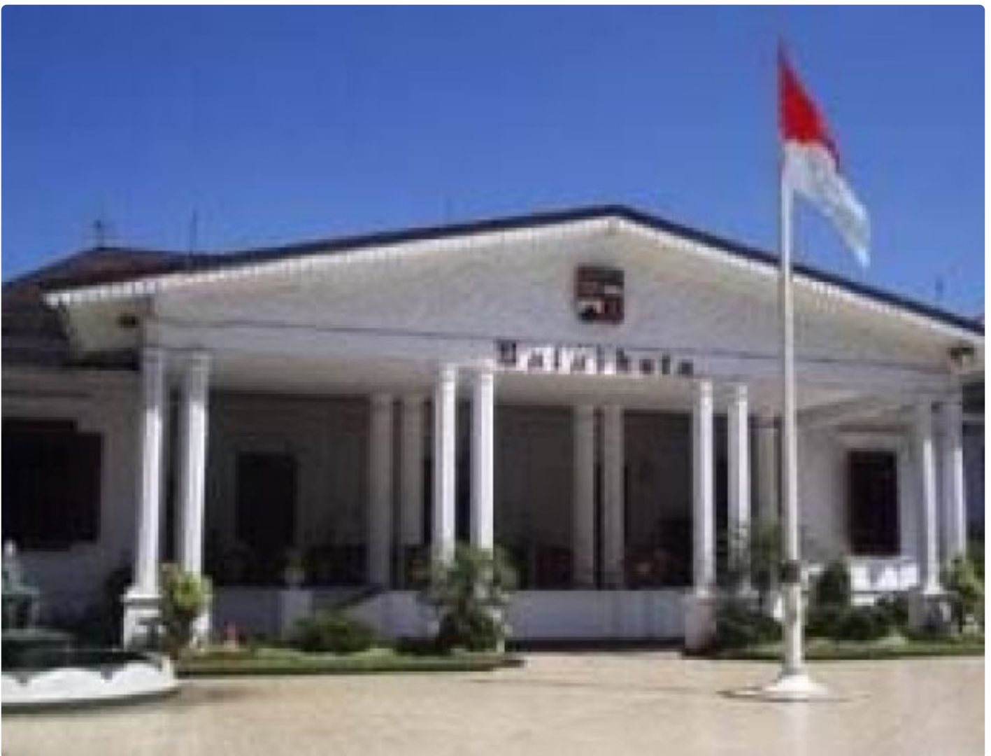
Photo Gedung Wali Kota Bogor
